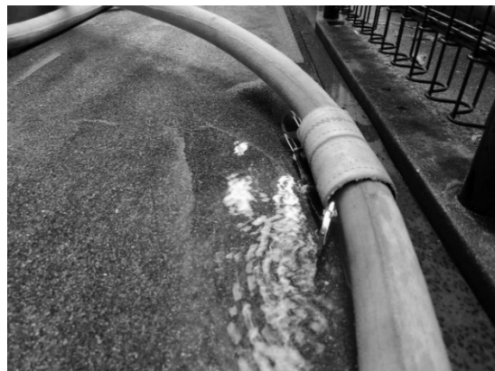
マルチ資器材を使用した漏水処置
